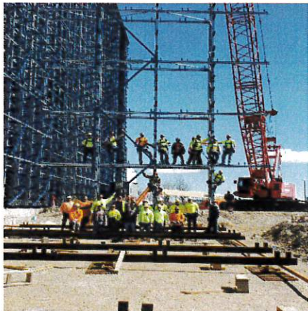
Americold Storage Rochelle, IL
